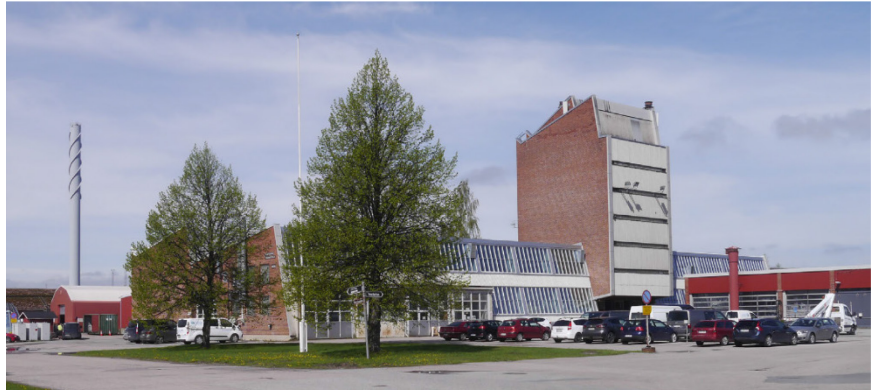
Konekorjaamo torneineen. KUVA: Rakennusinventointi, Arkkitehdit MY 2021
